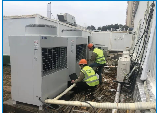
휘선산 병원의 공조기에 탑재된 에머슨 Copeland 디지털 스크롤 압축기
